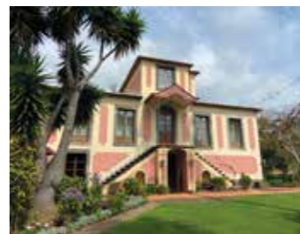
Façade principale de la maison
